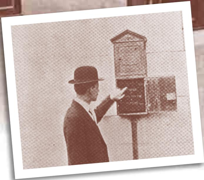
Central de avisos, instalação no quartel central. No detalhe, caixa de aviso de incêndio do Sistema Generst, instalado em 1885. • *Warning Central installation in the central barracks. Detail shows the Generst fire warning box, installed in 1885.*
