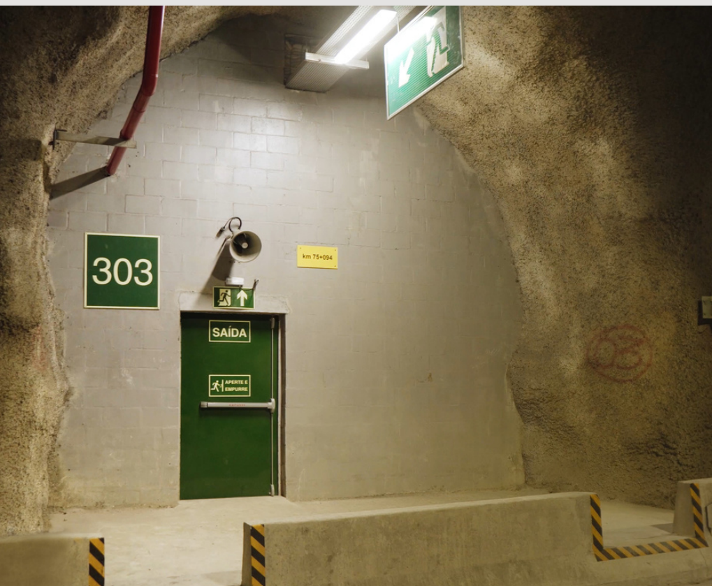
Parede com pintura intumescente resistente ao fogo
